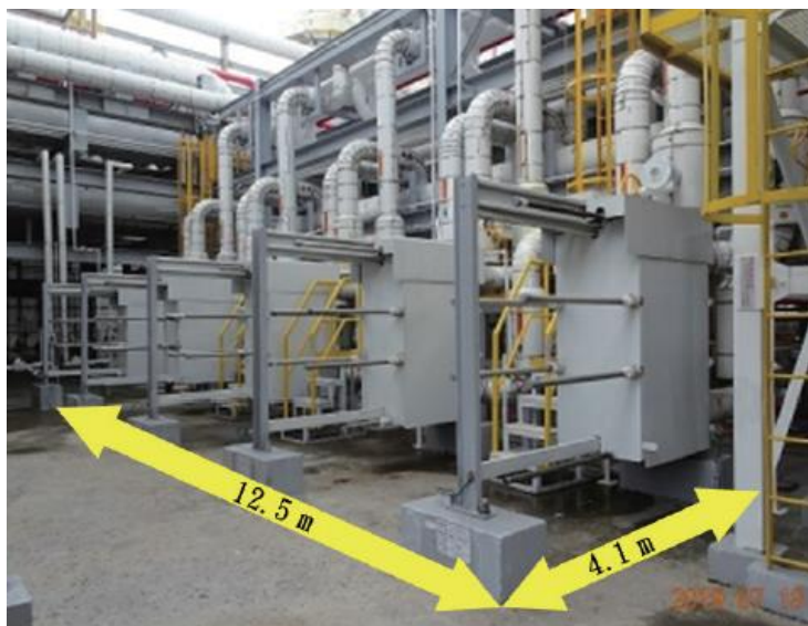
改善前 (5座半焊式板式熱交換器)
